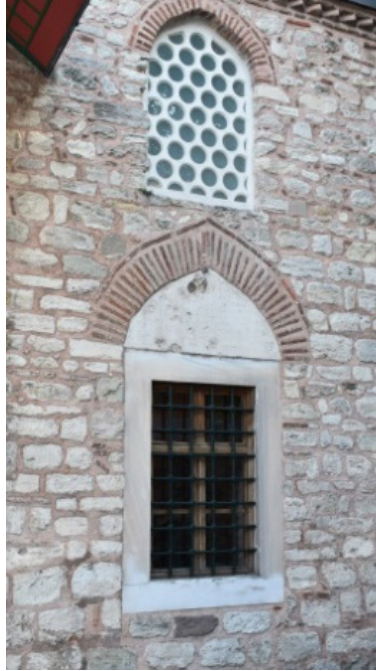
Foto. 10: Haseki Sıbyan Mektebi, kışlık dersane güney pencere
