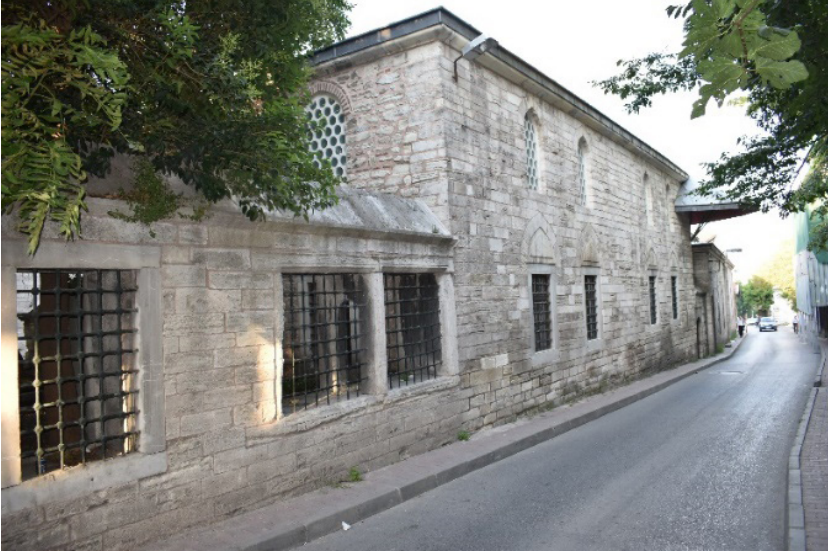
Foto. 3: Haseki Sıbyan Mektebi Haseki Caddesine bakan kuzey cephe kuzeydoğudan görünüm
