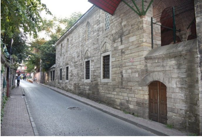
Foto. 2: Haseki Sıbyan Mektebi'nin Haseki Caddesine bakan kuzey cephe kuzeybatıdan görünüm
