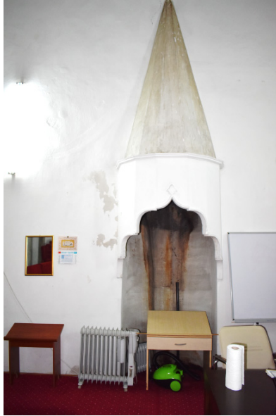
Foto 19: Şehzade Külliyesi Sıbyan Mektebi Ocak Nişi
