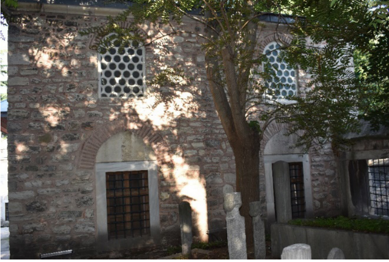
Foto. 7: Haseki Sıbyan Mektebi, kışlık dersane batı cepheden görünüm
