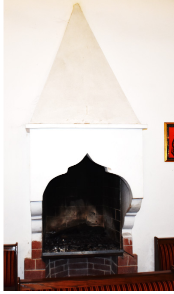
Foto 19: Şehzade Külliyesi Sıbyan Mektebi Ocak Nişi
